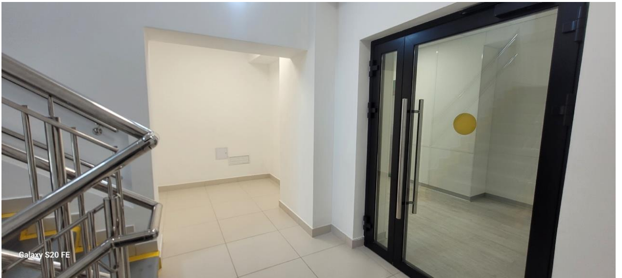
Противопожарные карманы с кнопкой экстренного вызова
